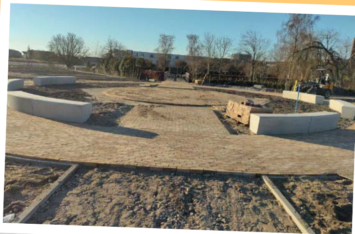
| Aanleg uitbreiding begraafplaats Roelofarendsveen
